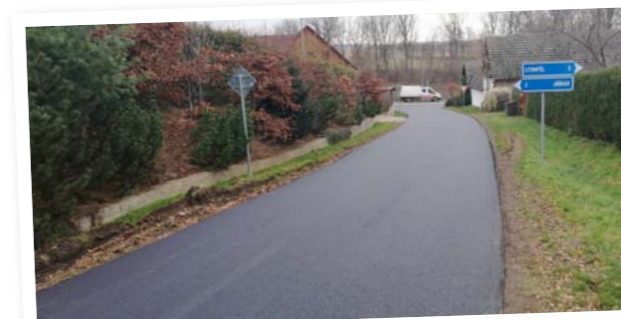
Nový povrch silnice na Osík
