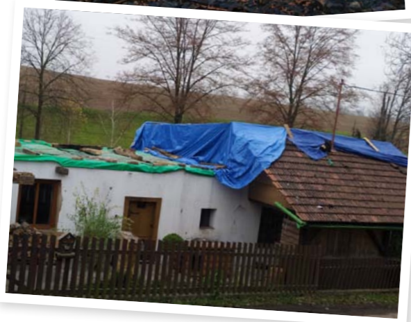
Požár domu čp. 3 a jeho současný stav
